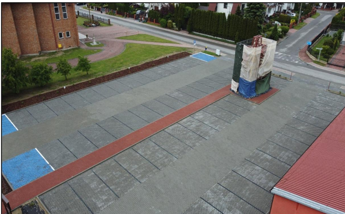
Parking ul. Żapniowska - 49 miejsca postojowe + 3 miejsca dla osób niepełnosprawnych
